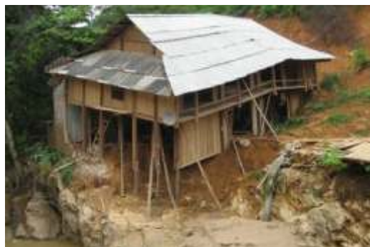
Nhà tạm bên núi (Nguồn: Dự án CACC)
